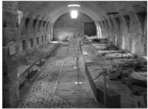
Fig. 2. Planta baja del Molino de Martos, con bóveda de cañón y, a la derecha, lugar para diez piedras de moler; A la izquierda en el suelo se ven las aberturas (aguatochos) para desviar el caudal introduciendo tablas.
