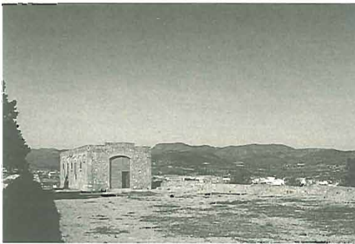
(Lámina V: Vista exterior Edificio Sala de Exposiciones en el albacar interior del Castillo)
